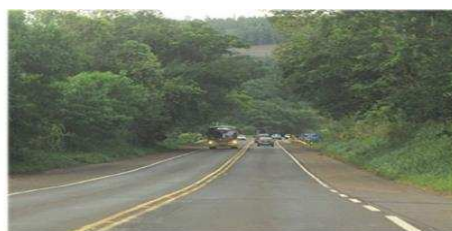
RODOVIA DE PISTA SIMPLES
